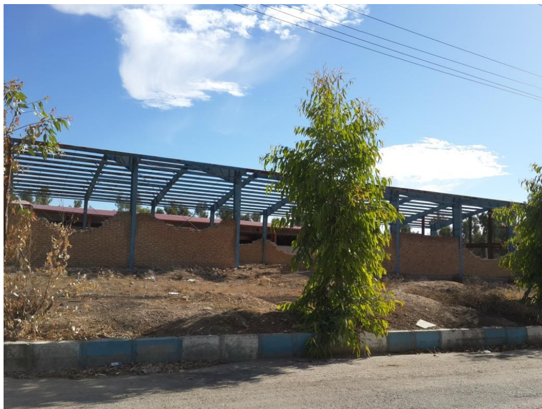
شکل ۱۲- عدم مهار مناسب دیوارها پیرامونی به اعضای سازه‌ای در یک ساختمان سوله صنعتی
