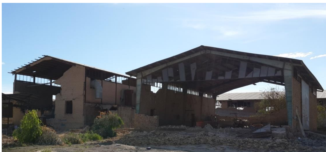
شکل ۱۳- تخریب اعضای غیرسازه‌ای در عین پایداری کلی ساختمان‌های سوله صنعتی
