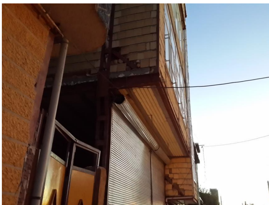
شکل ۴- تحمیل تغییرشکل دائم به ساختمان
