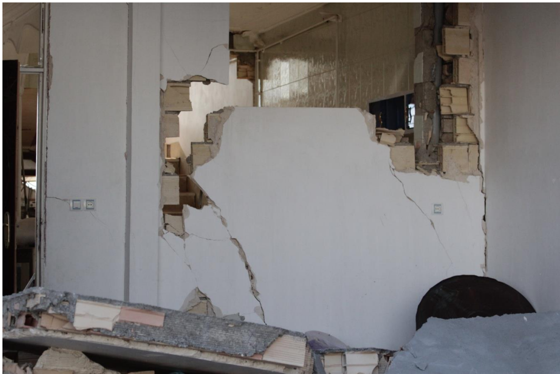
شکل ۱۰- عدم استفاده از جزئیات مناسب به منظور مهار دیوارهای غیرسازه ای
