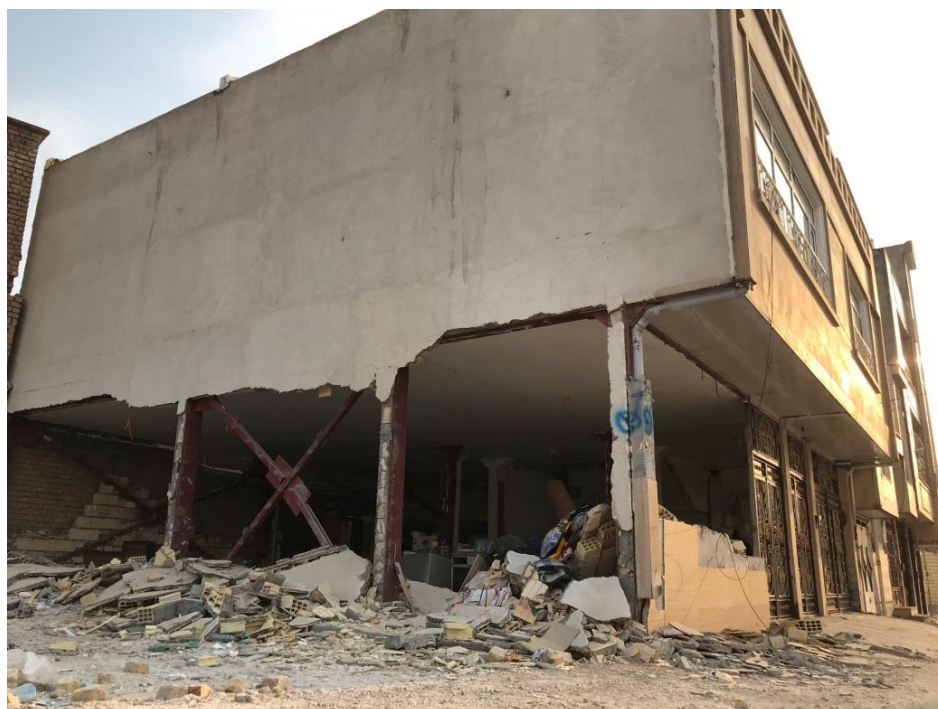
شکل ۳- کمانش مهاربند و تخریب دیوار غیرسازه ای
