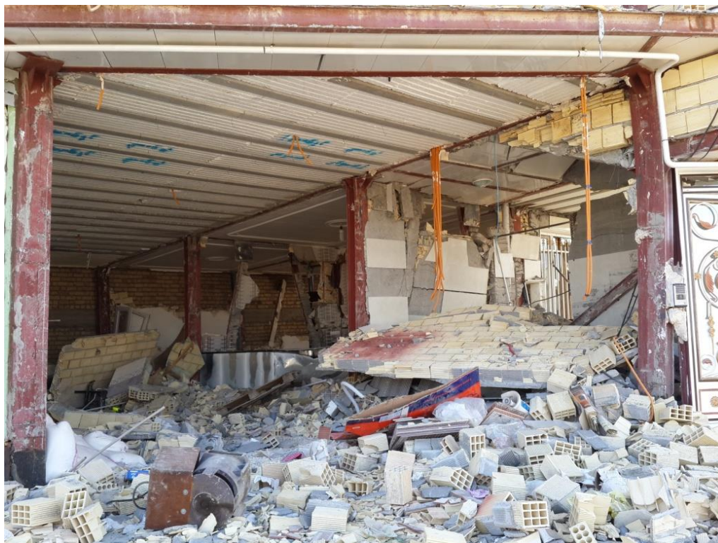
شکل ۵- تخریب دیوارهای غیرسازه‌ای به دلیل تغییرشکل‌های زیاد
