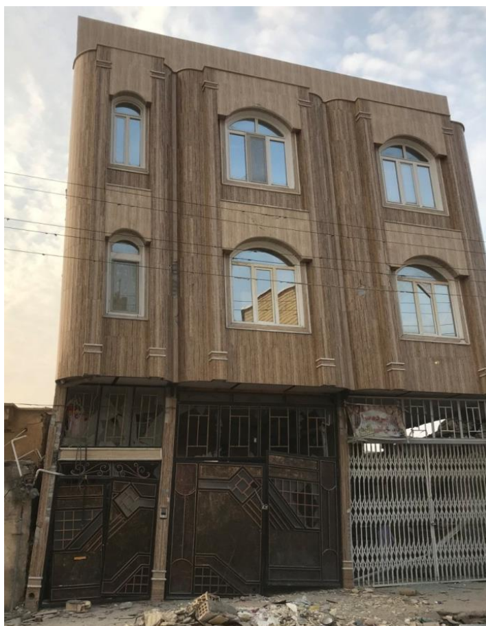
شکل ۱۴- تغییر شکل ماندگار قابل توجه در جهت مهاربندی نشده ناشی از عدم کفایت مقاطع در تحمل بارهای جانبی
