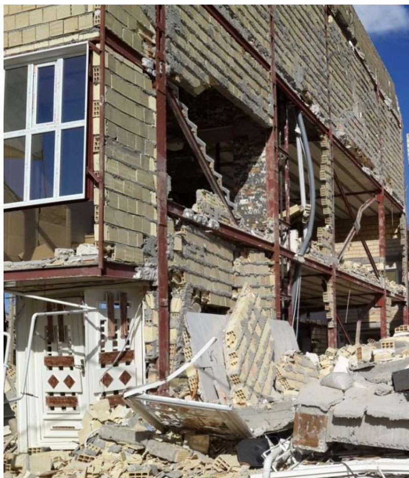
شکل ۱- کماتش خارج از صفحه‌ی مهاربندها
