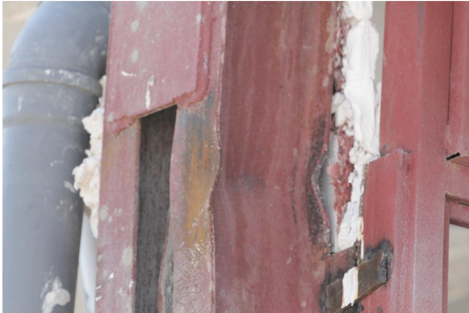
شکل ۱۶- عدم کفایت مقطع ستون و کمانش کلی و موضعی آن
