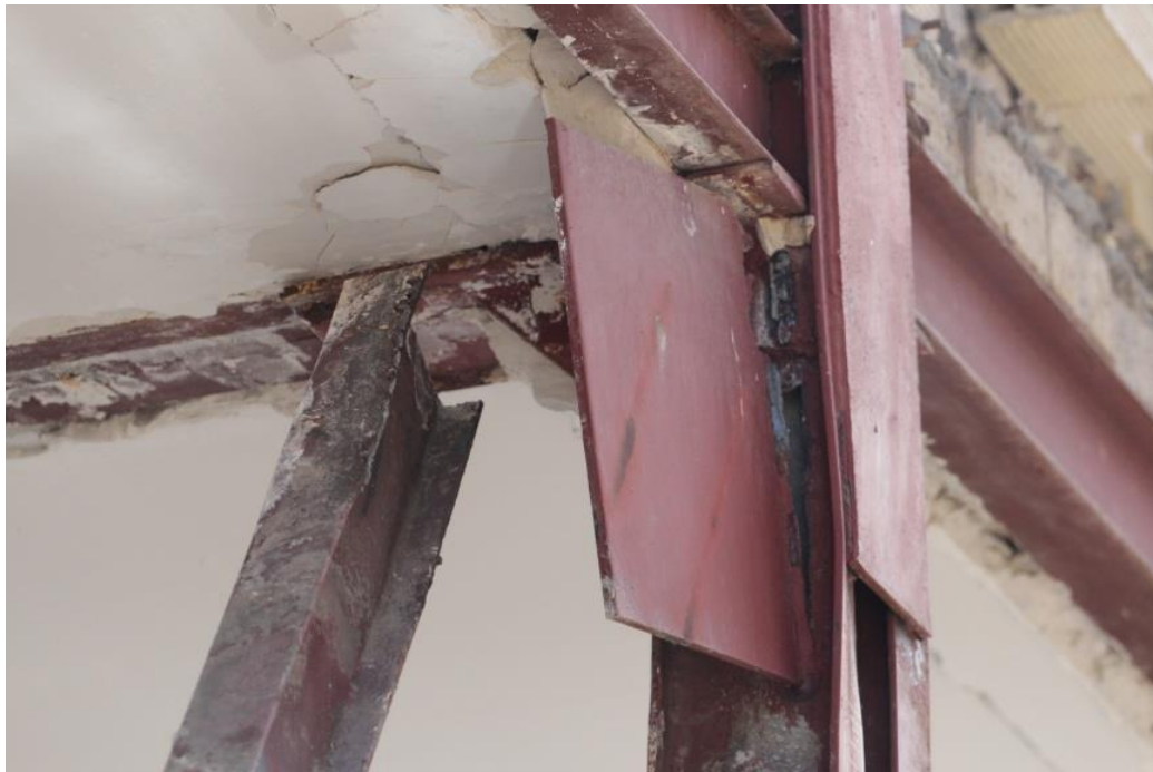
شکل ۸- شکستن جوش اتصال ورق اتصال مهاربند به ستون و همچنین عدم اتصال این ورق به تیر فوقانی
