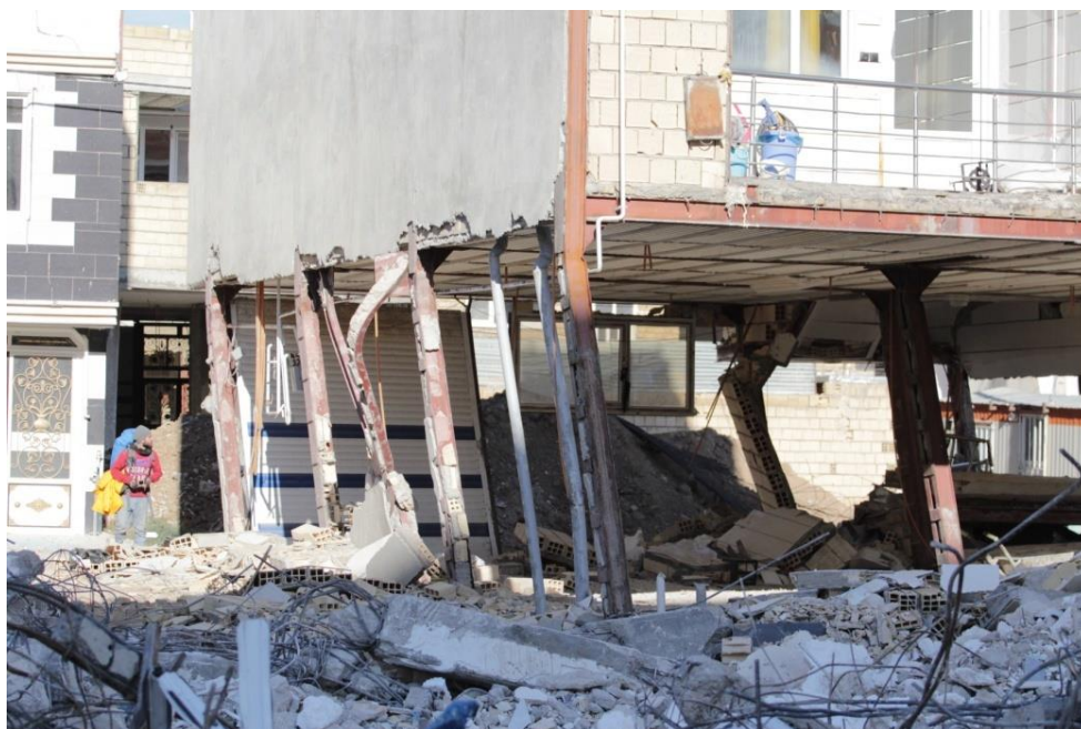
شکل ۲- کماتش خارج از صفحه مهاربند و تخریب دیوارهای غیرسازه‌ای به دلیل تغییر شکل‌های زیاد
