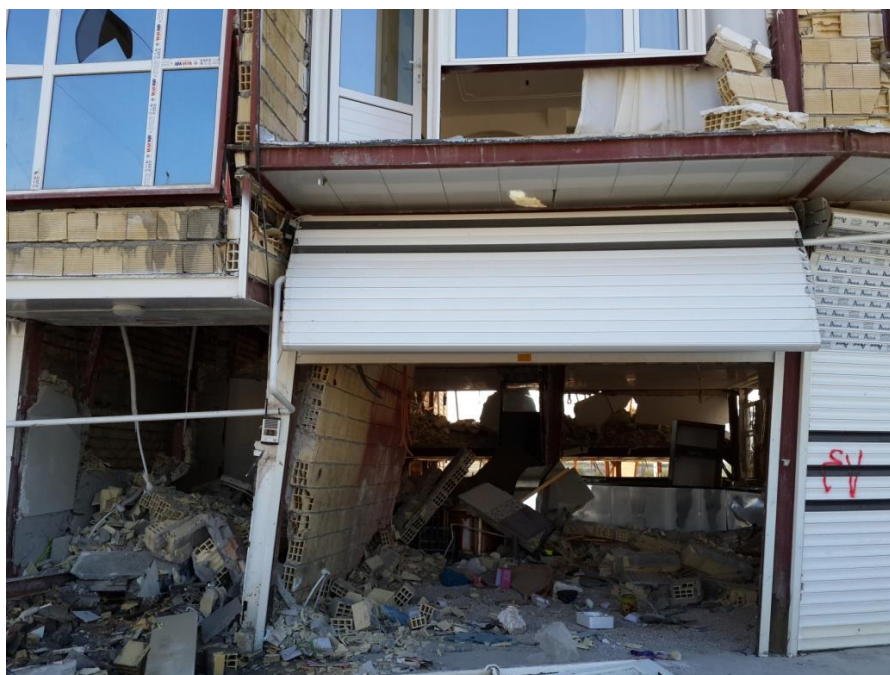
شکل ۱۵- تغییر شکل ماندگار قابل توجه در جهت مهاربندی نشده به دلیل وجود طبقه نرم و تخریب دیوارهای غیرسازه ای در اثر تغییر شکل های زیاد
