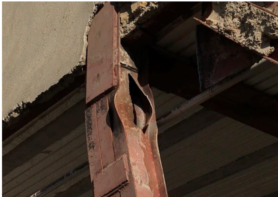
شکل ۱۷- عدم کفایت جوش اتصال مهاربند به ستون، ظرفیت ناکافی ستون و کمانش کلی و موضعی آن
