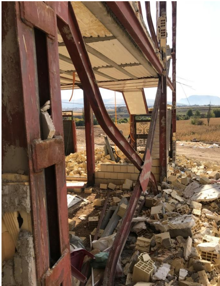
شکل ۶- کمانش خارج از صفحه‌ی مهاربند، تخریب پیچشی و ریزش دیوارهای غیرسازه‌ای
