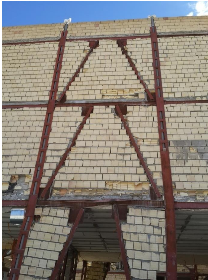
شکل ۷- استفاده از سیستم سازه‌ای نامناسب و عدم کنترل تیرهای پیوند برای نیروهای نامتعادل ناشی از مهاربند خارج از مرکز
