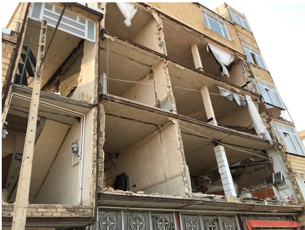
شکل ۱۱- تخریب اعضای غیرسازه ای در عین پایداری کلی سازه
